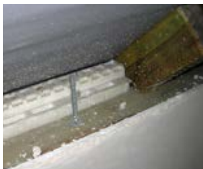
Element MP pozwala na ułożenie zbrojenia wieńca w osi ściany oraz oparcie stropu.
