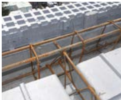
Element MP pozwala na ułożenie zbrojenia wieńca w osi ściany oraz oparcie stropu.
