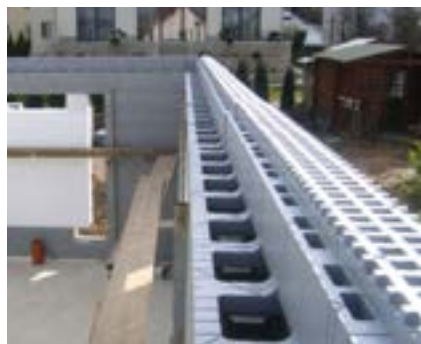
Element wieńcowy MP posiada zewnętrzną warstwę izolacji taką samą jak cała ściana
