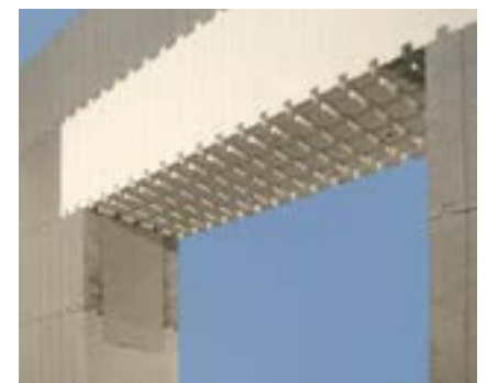
Nadproże. Element nadprożowy w przekroju ma kształt litery U.
