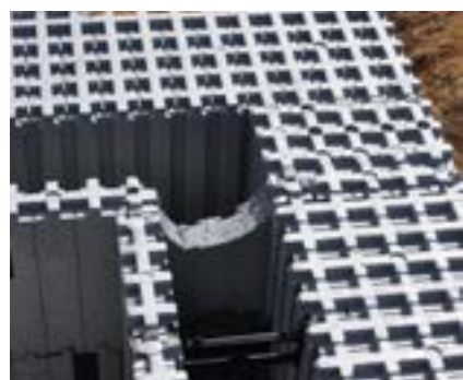
Usunięcie fragmentu elementu zapewnia ciągłość wypełnienia betonem.
