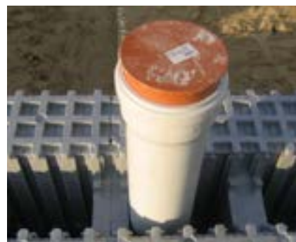
Element MP pozwala na ułożenie zbrojenia wieńca w osi ściany oraz oparcie stropu.
